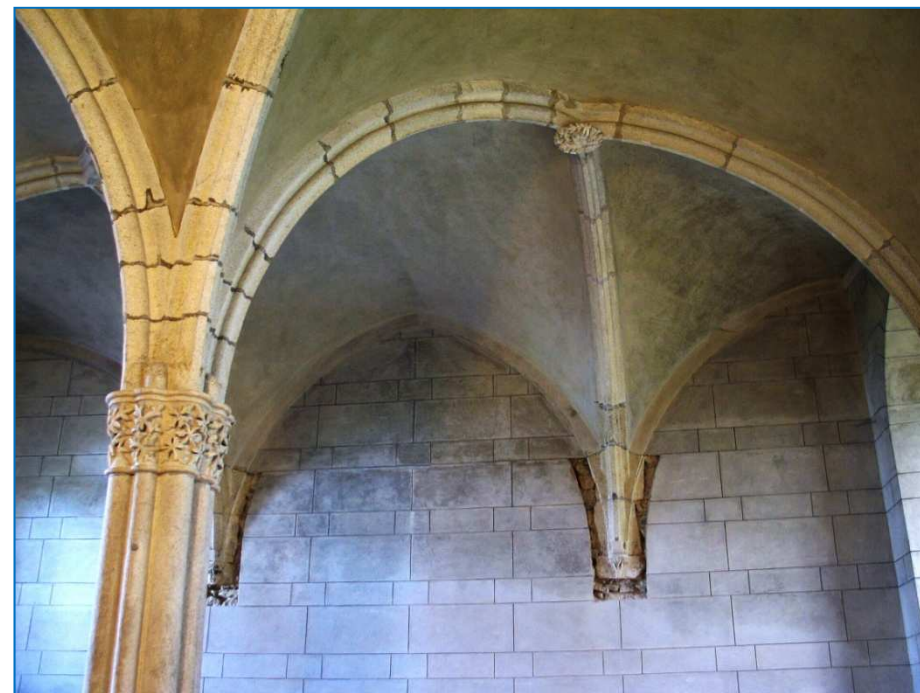
Gewölbe des Kapitelsaals, in dem Zawisch von Falkenstein begraben liegt. © Zisterzienserkloster Vyšší Brod, 2010
