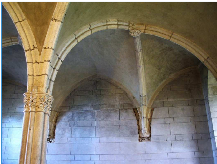
Detail klenby kapitulní síně, ve které je pohřben Závíš z Falkenštejna. ©Cisterciácký klášter Vyšší Brod, 2010
